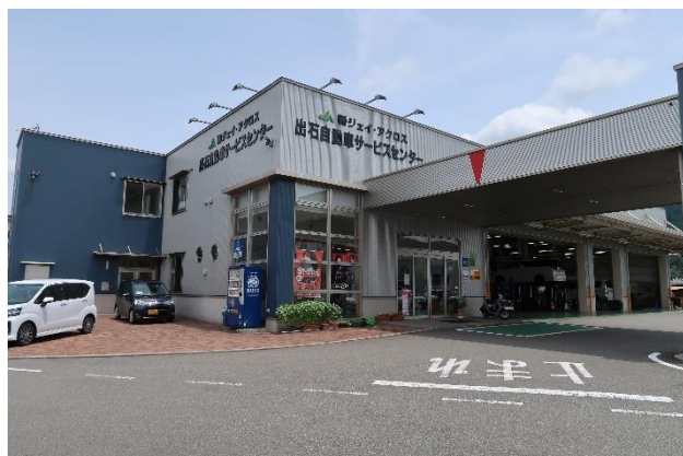
出石自動車サービスセンター
